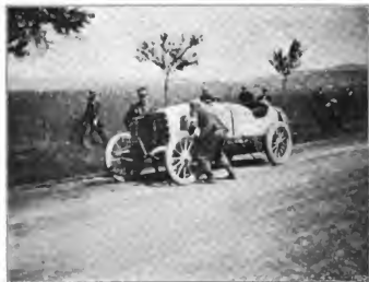
Bougier (Turcat-Mery) Nr. 18 muss eine halbe Stunde auf der Strecke liegen bleiben, um den vollgekauften Schwimmer zu reparieren und wird infolgedessen trotz sonst glänzender Fahrt böse Victor. (phot. Ing. Bohm.)
